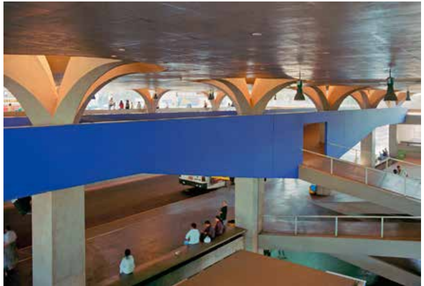
O projeto da Rodoviária de Jau (1973) é um exemplo da liberdade no alcance técnico da solução estrutural que transforma as peças tradicionais da estrutura – o pilar e a viga – absolutamente integrada ao programa e à cidade
